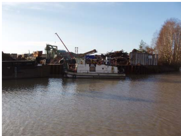
am westlichen Ende des Parallelhafens plant die Theo Steil GmbH den Neubau eines zusätzlichen Umschlagplatzes für GMS
