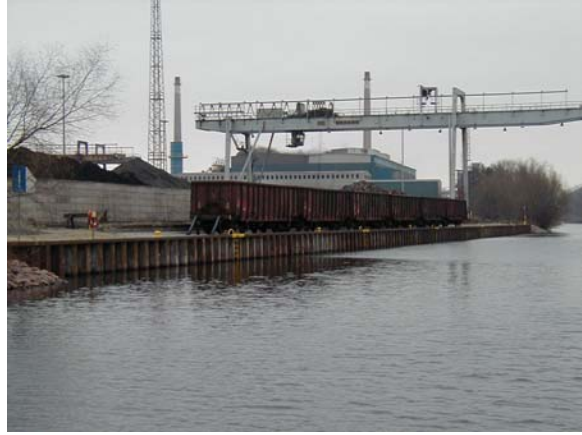
neuer Hafen bei HOW km 13,8 nach der Grundinstandsetzung, Ansicht von Süden
