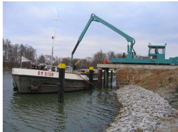
20.12.04 – erster planmäßiger Umschlag an der Umschlagstelle Bralitz, WAO km 2,30
