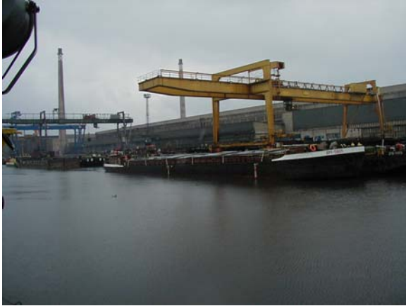
Hafen der Hennigsdorfer Elektrostahlwerke GmbH bei HOW km 15, Ansicht von Norden
